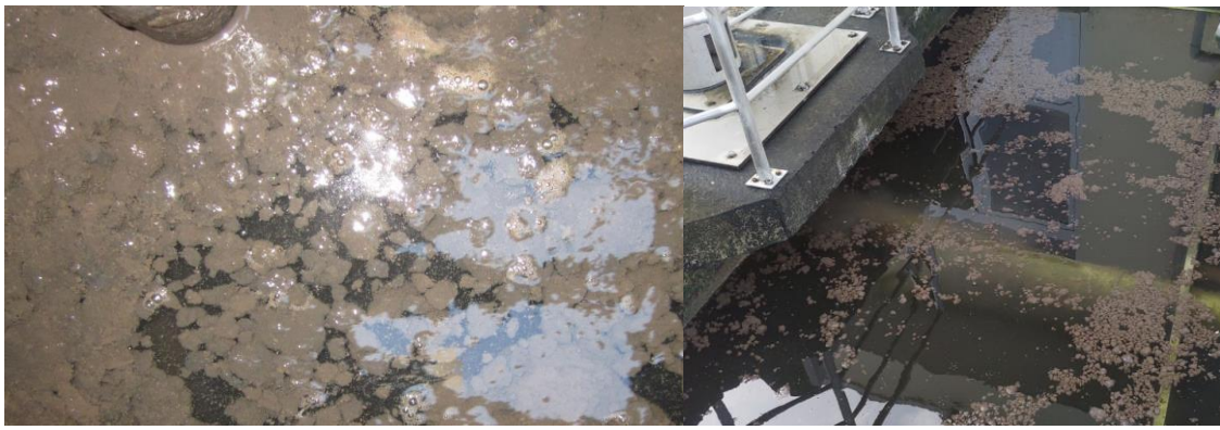
Hình 5. Bùn nổi tại bể lắng
